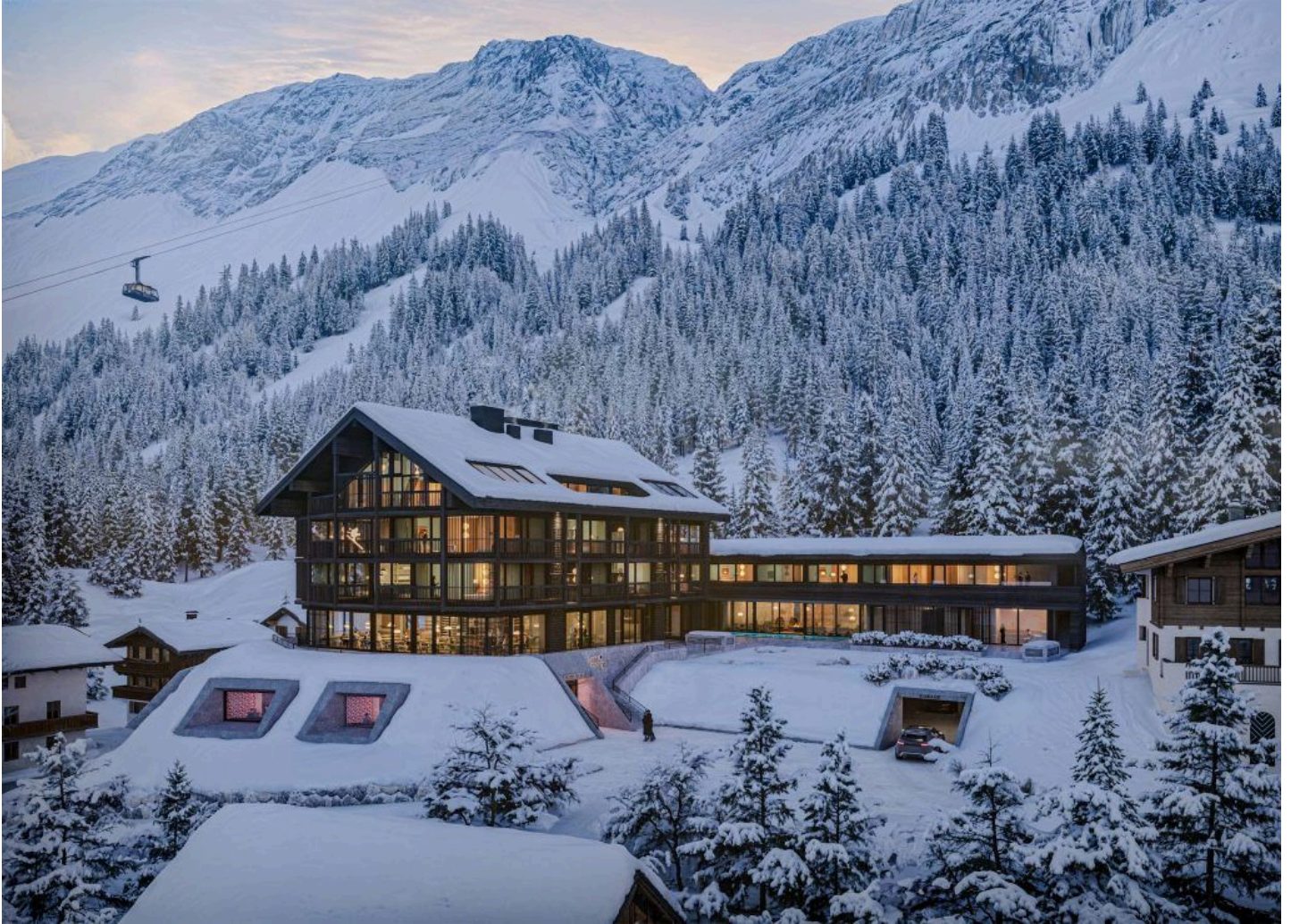
Die Visualisierung zeigt das Hotel Kristberg nach der Fertigstellung. FRAME 9 – DIPL. ING. TOBIAS COLZ
